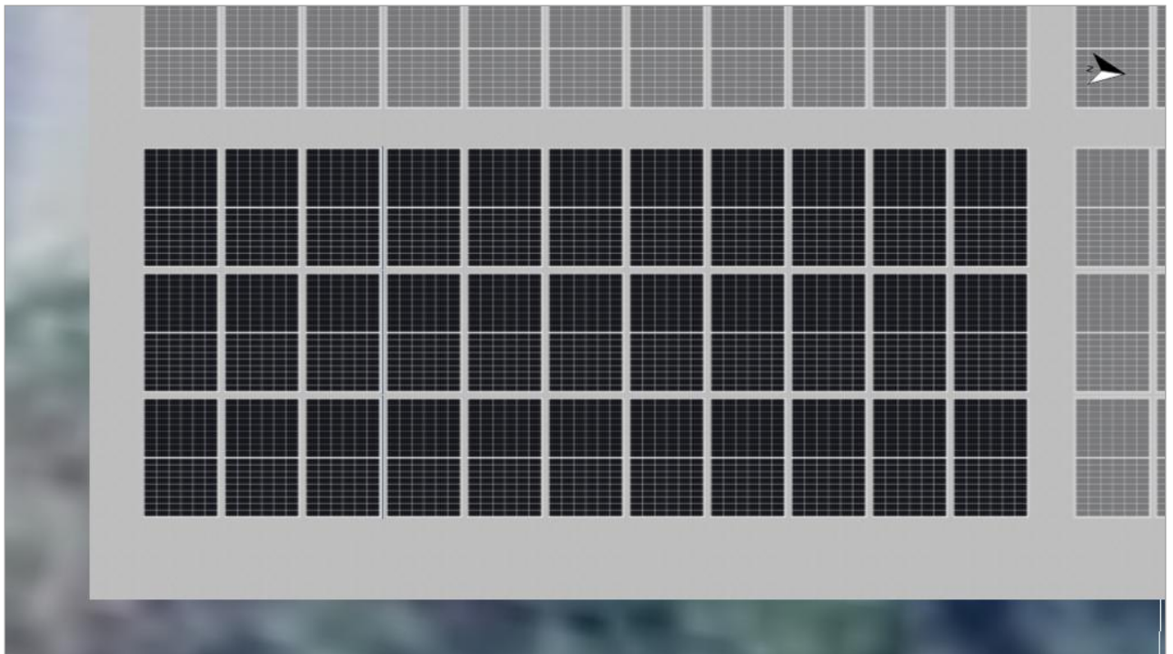
Abbildung: 63. Modulfläche - Gebäude 03-Dachfläche Ost
